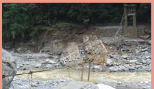
नामरूङ्ग र पालुङ्ग गाउँलाई जोड्ने क्षतिग्रस्त झोलुङ्गे पुल
